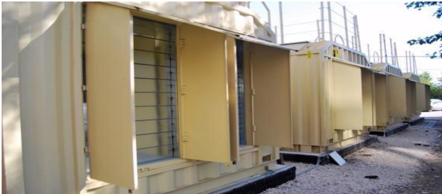
Проект: Энергокомплекс суммарной мощностью 7,8 МВт для ООО «Мэйл.Ру» в рамках строительства центра обработки данных (ЦОД) «М 100». Главная задача - обеспечение бесперебойного и гарантированного электропитания ЦОД «М 100».
